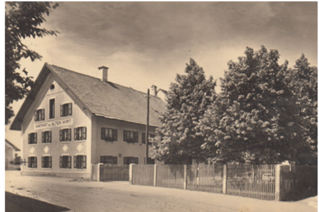
Alter Wirt in Engelschalking – Schießstände waren im Speicher
